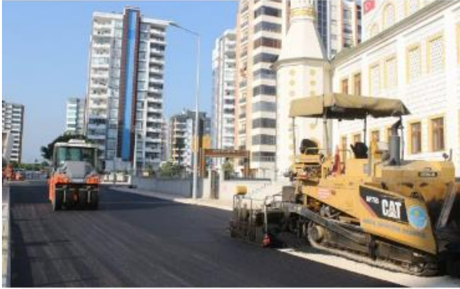
BÜYÜKŞEHİR, ASFALT ÇALIŞMALARINI YOĞUNLAŞTIRDI
